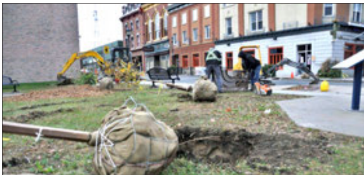
Quelque 94 arbres remplacent les frênes coupés en mesure préventive.
